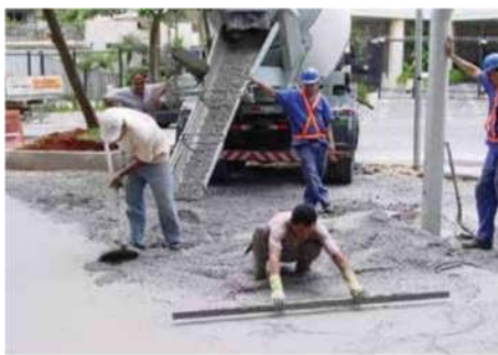
Figura 8 - Recebimento e espalhamento do concreto.
