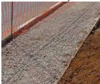
Figura 7 - Espalhamento da camada de Brita
